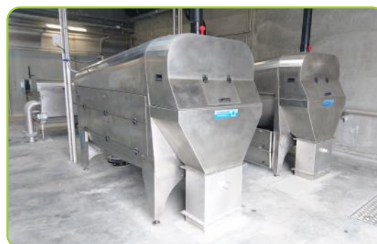
Forafvanding af slam - Solrødgaard Renseanlæg, Hillerød
