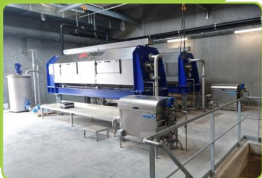
Slamafvanding med IEA skruepresse - Solrødgaard Renseanlæg, Hillerød
