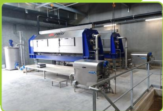
Slamavvattning med IEA skruvpress - Solrødgaard Reningsverk, Hillerød
