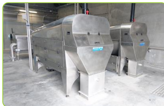
Föravvattning av slam - Solrødgaard Reningsverk, Hillerød
